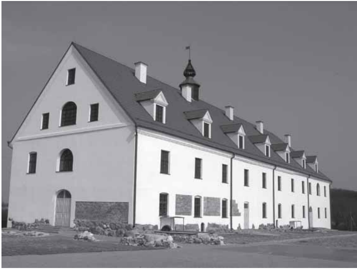
Restauruotas Kražių kolegijos bursos pastatas. 2007 m.
